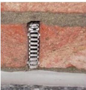
Open stootvoeg met bijenbekje en locatie bij doorgelegde vloer
