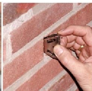
Open stootvoeg met bijenbekje en locatie bij doorgelegde vloer
