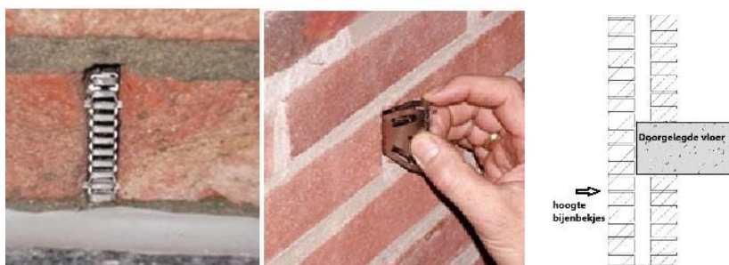
Open stootvoeg met bijenbekje en locatie bij doorgelegde vloer
