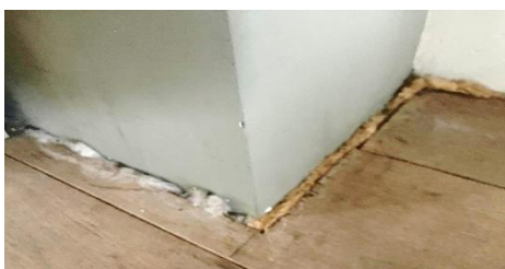
Figuur 7. Isolatie tussen vloer en gevel.
