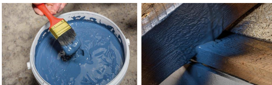
Figuur 1. Balken afwerken met een vloeibare afdichting
