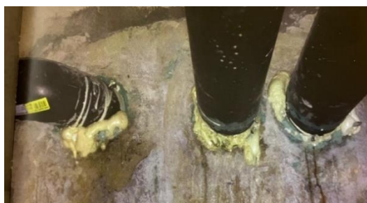
Figuur 6. Geïsoleerde doorvoerleidingen
