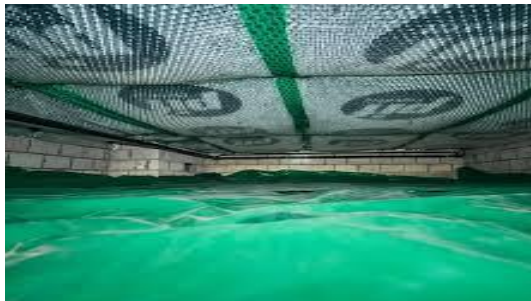
Figuur 4. Luchtdicht getapete aansluitingen
