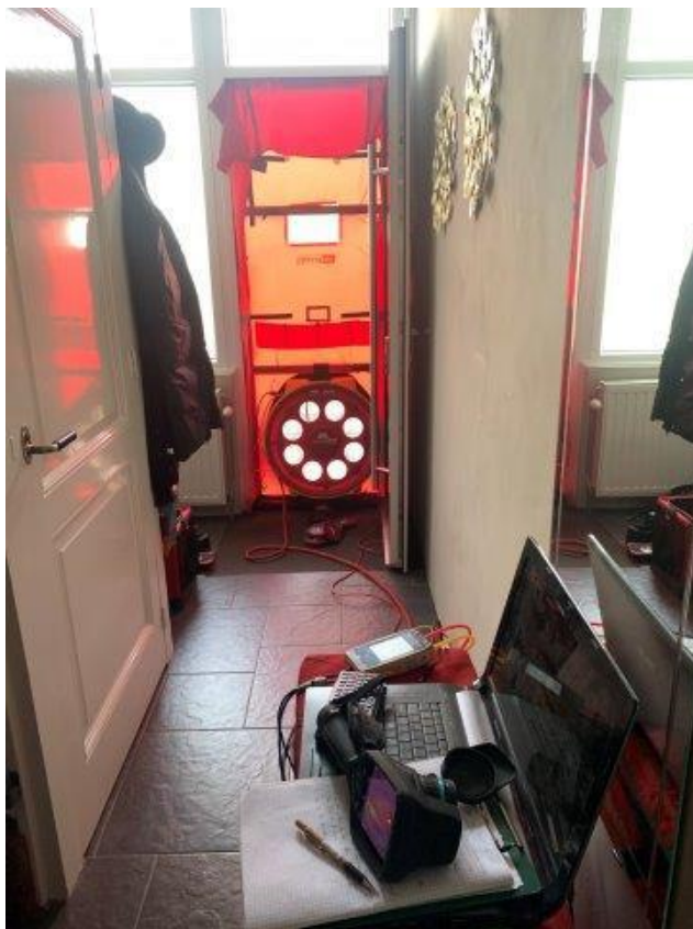
Blowerdoor (meetventilator) in de voordeur
