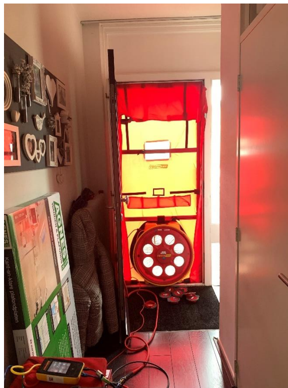
Blowerdoor (meetventilator) in de voordeur
