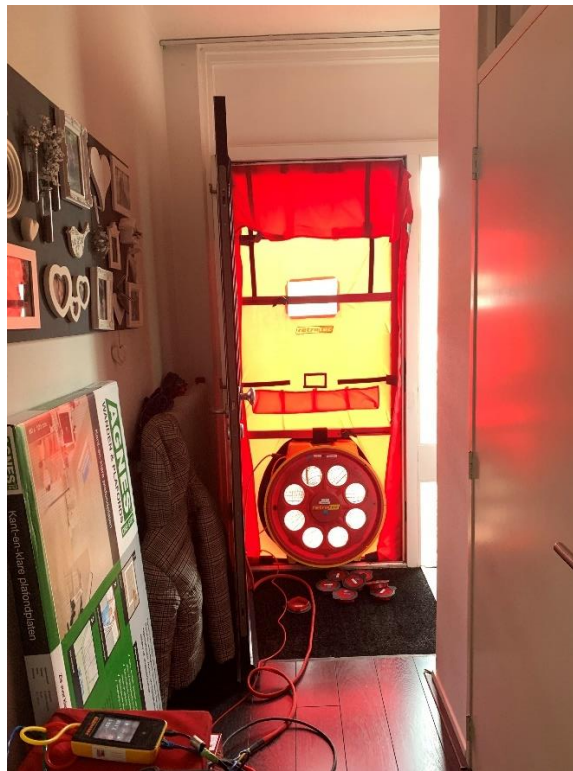
Blowerdoor (meetventilator) in de voordeur
